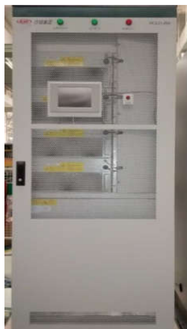
图 12 PCS31-250 DC/DC 变换器 Fig. 12 DC/DC converter of PCS31-250
